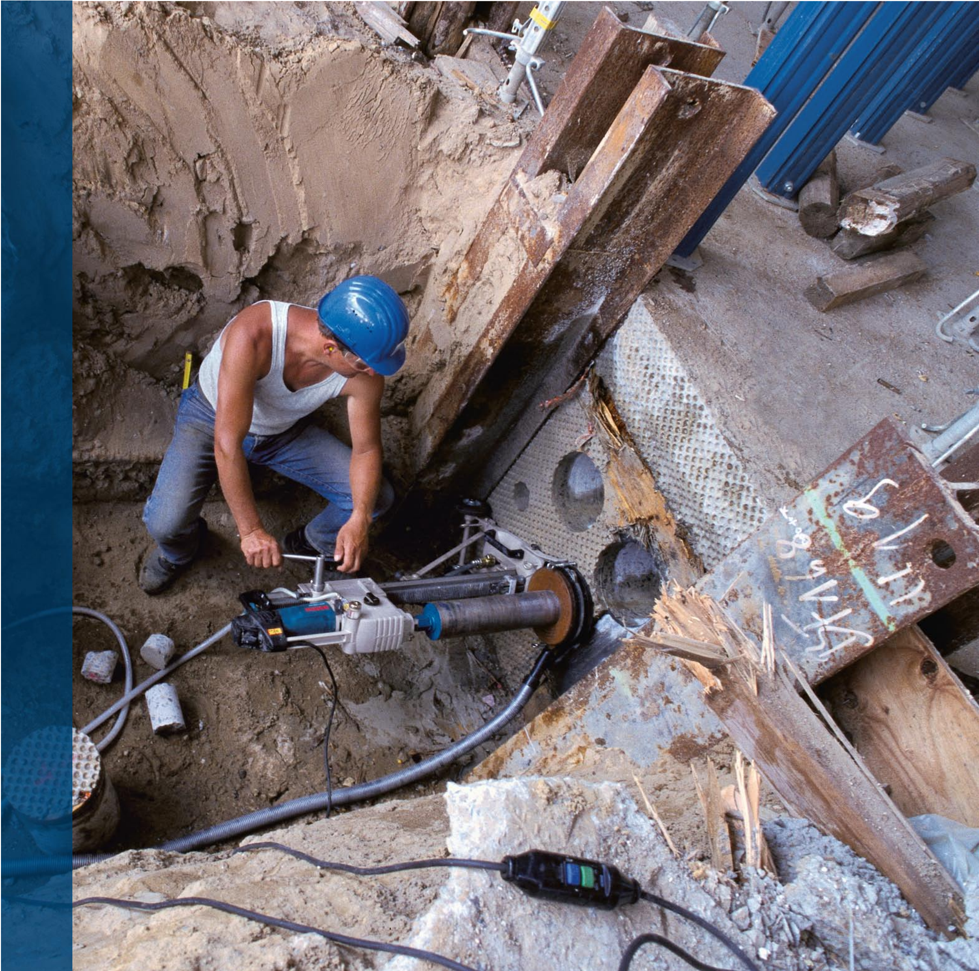
Particulièrement puissant, l'appareil de forage diamant GDB 2500 WE Professional perce le béton armé sans vibrations.
